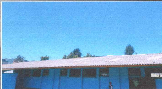
Foto 1: Se puede observar de como se encuentra la lamina fibrocemento en el modulo a trabajar.
